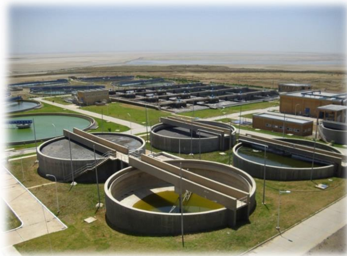
Figure 9 : La station d'épuration d'El Karma, Wilaya d'Oran.
