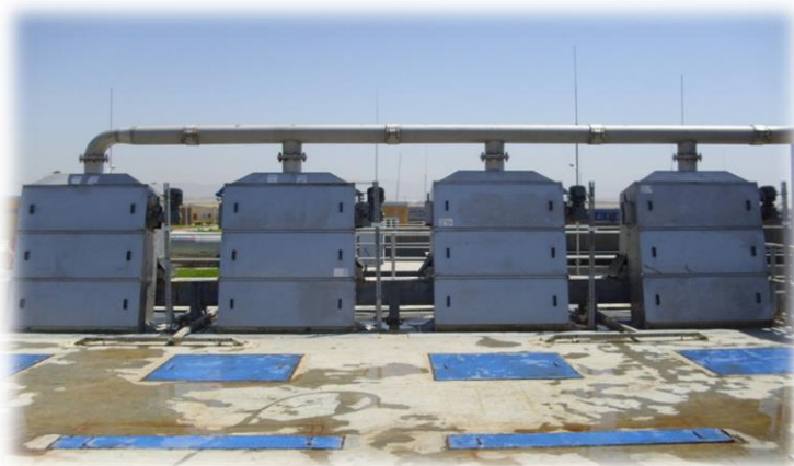
Figure 10 : Dispositif de dégrillage.
