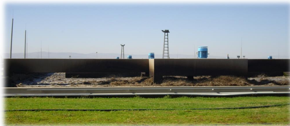
Figure 13 : Aérateur de surface.
