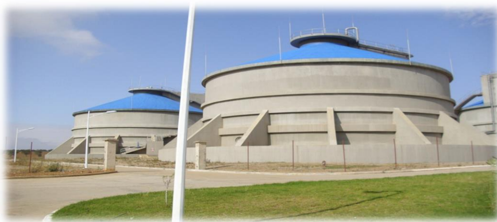
Figure 14 : Cinq digesteurs anaérobiques.
